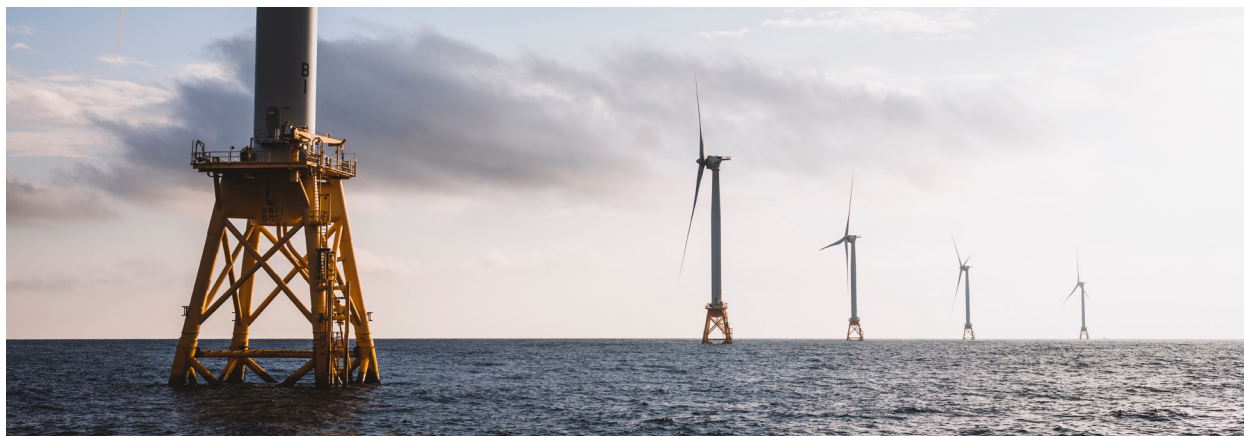
Cinco turbinas del proyecto eólico marino Block Island. (Adobe Colección de imágenes)
